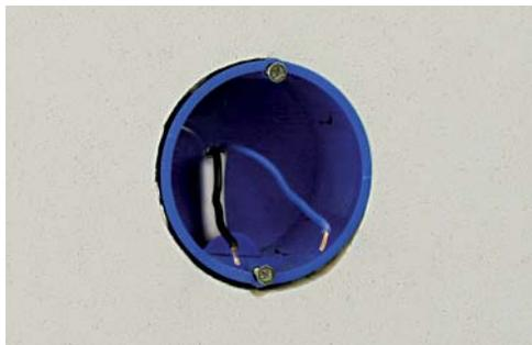
Требования к коробке: диаметр 65-68 мм, глубина 40 мм и более, межосевое расстояние для 2-х и более коробок 71 мм.
