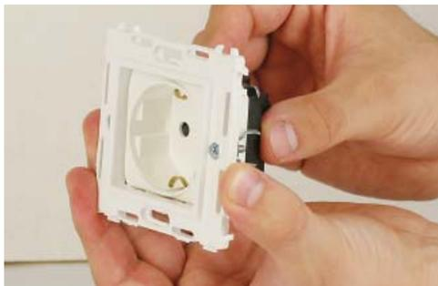
Вставьте в каркас для настенной установки (на фото - каркас код 75020W) электроустановочное изделие серии "Brava" (на фото розетка 76482B).
