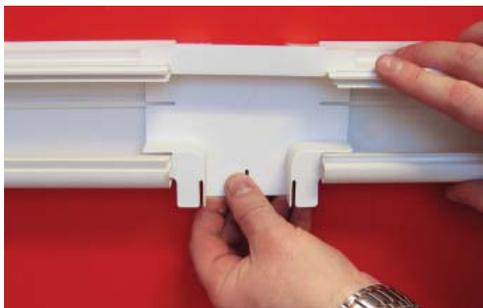
Вставьте базу тройника между двумя коробами прямой трассы. Закрепите короба на стене
