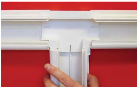
Вставьте в базу тройника отводящий кабель-канал. Закрепите его на стене
