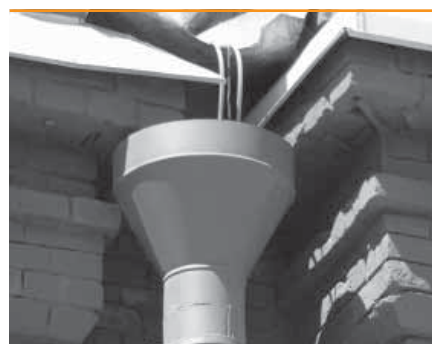
7 водосточные трубы и воронки
